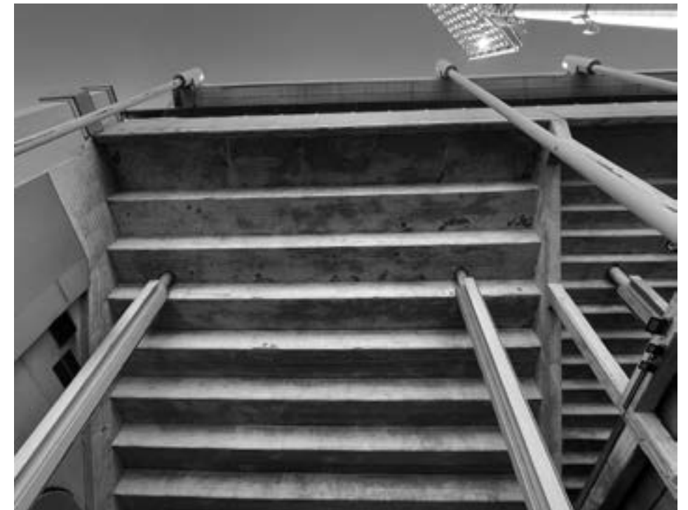
Figg. 11/13 –Illustrazione degli accostamenti delle strutture in c.a. con le aggiunte e modifiche postume.
